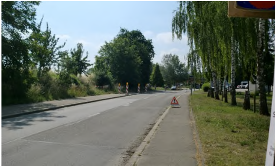
Bild 9: Wössinger Straße mit Böschungsbereich
